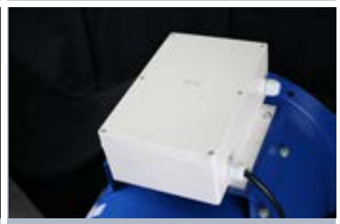
✓ Caja de conexiones instalada en el envoltente
