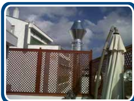
EXTRACCIÓN DE HUMOS, SITGES
