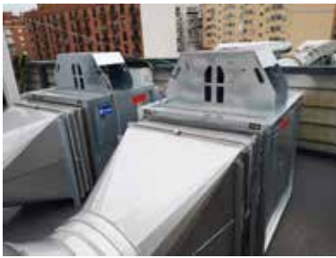
Extracción en cocina de supermercado DHUMAT, BOX RLF, BOX BV PLUS, BOX BV
