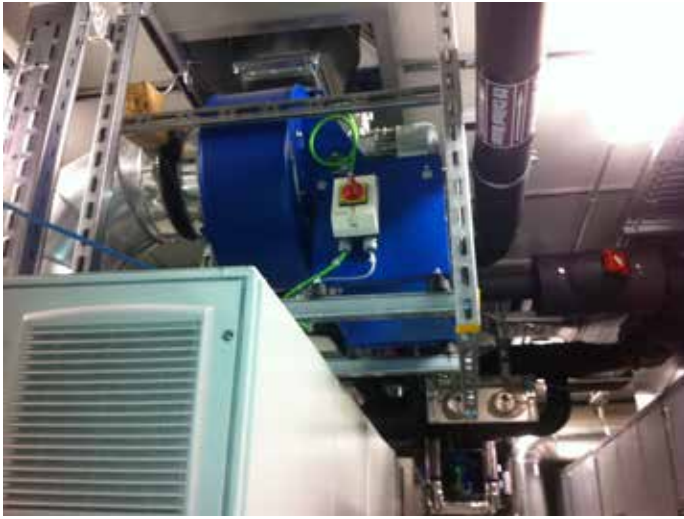
Fábrica de Jaguar Land Rover, a AVL Powertrain Technical Center, Ansty Business Park, Coventry (Reino Unido) MBX ATEX con carcasa antideflagrante para atmósferas explosivas clase Ex-d
