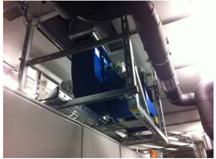
Fábrica de Jaguar Land Rover, a AVL Powertrain Technical Center, Ansty Business Park, Coventry (Reino Unido) MBX ATEX con carcasa antideflagrante para atmósferas explosivas clase Ex-d
