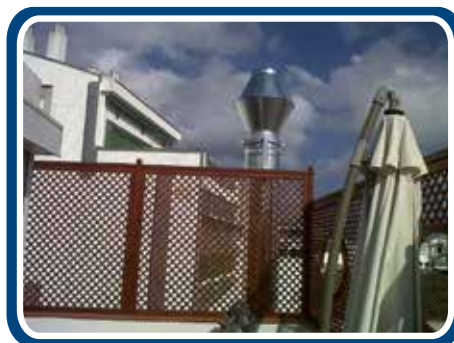
EXTRACCIÓN DE HUMOS, SITGES
