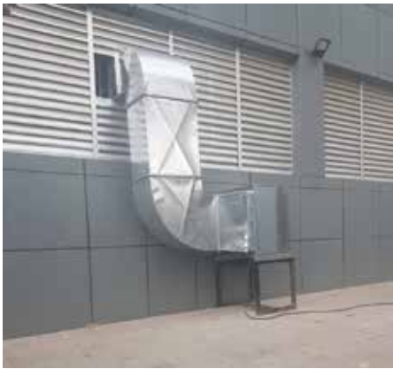
Instalación de ventilación para campana profesional en Etiopía BOX HB
