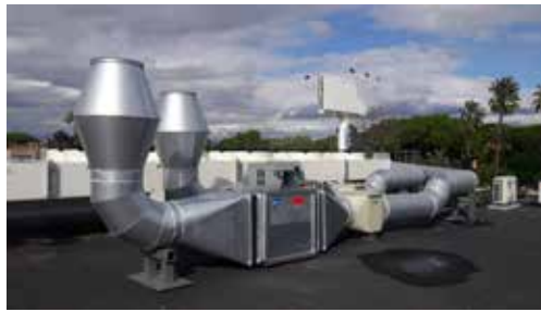
Extracción en cocina de supermercado DHUMAT, BOX RLF, BOX BV PLUS, BOX BV
