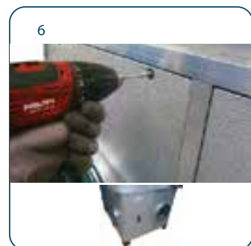
Atornillar los paneles
