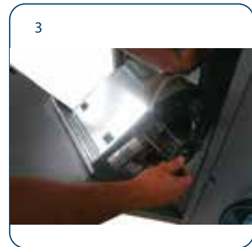
Desenroscar y quitar el panel frontal con el ventilador
