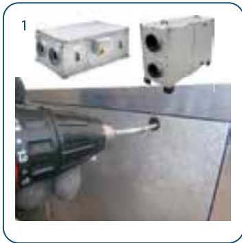
Desenroscar el panel lateral
